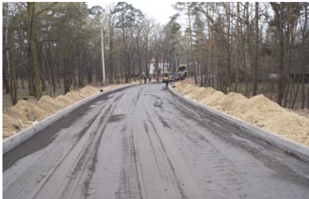
Mieszanka betonowa popiołowo-żużlowa UTEX-CEN, zastosowana do wykonania podbudowy zasadniczej drogi lokalnej w Piasecznie k. Warszawy
