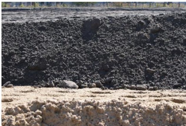
Budowa mostu Północnego w Warszawie – przekrój warstwy nasypu z wykorzystaniem kruszywa z żużli paleniskowych UTEX-CEN
