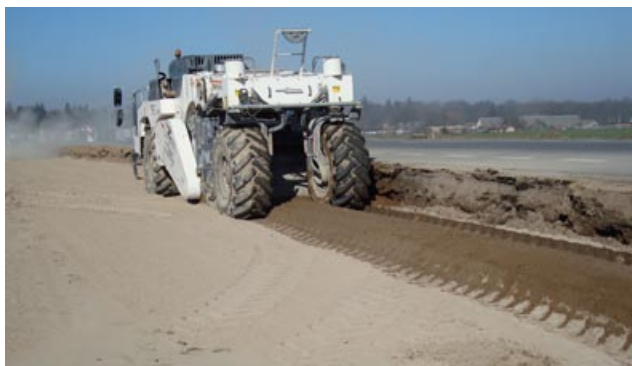
Proces mieszania gruntu rodzimego z użyciem „Spoiwa drogowego do ulepszenia i osuszania gruntów TEFRA 15”. Przebudowa drogi S7 na odcinku Elbląg-Kalsk
